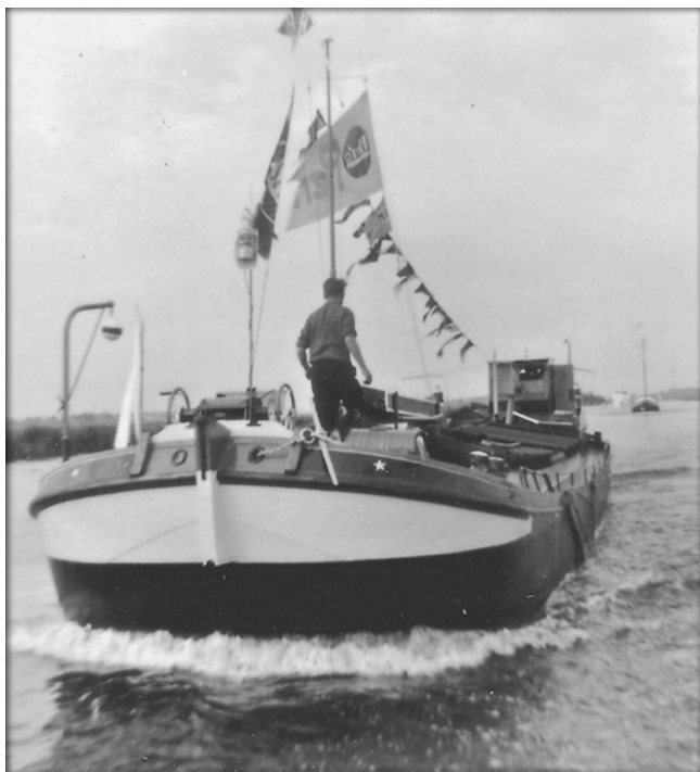
1967 - De -Grietje- op proefvaart in Friesland, motor ingebouwd bij Doornbusch te Winsum
