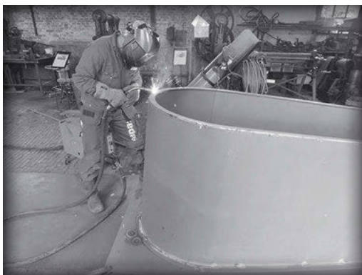
De schoorsteen voor de Marrot in aanbouw.
